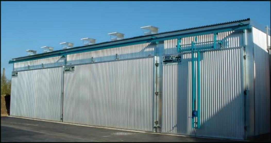
Традиционные сушильные камеры конвективного принципа действия объемом от 50 до 300 м³
