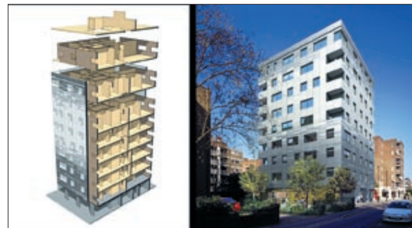
Рис. 5. Девятиэтажное деревянное здание, построенное по панельной технологии, Лондон
