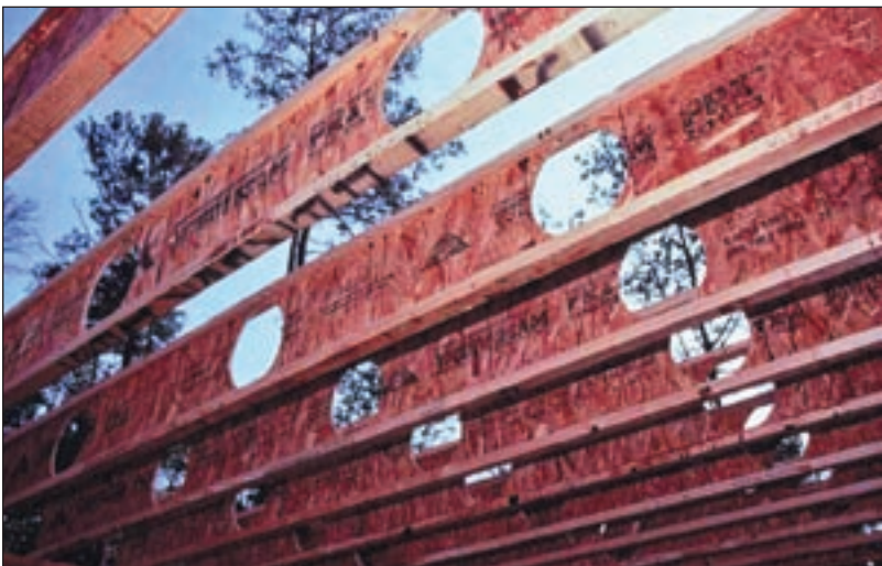
Рис. 2. Двухтавровая балка, используемая для широкопролетных зданий
